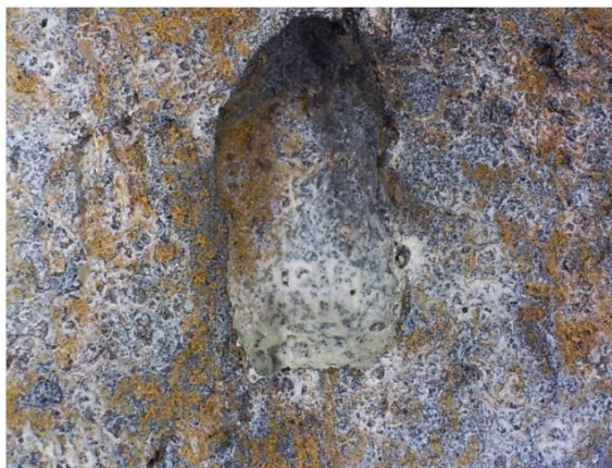
Obr. 2 Důlková koroze. Detail korozního důlku. (5)
