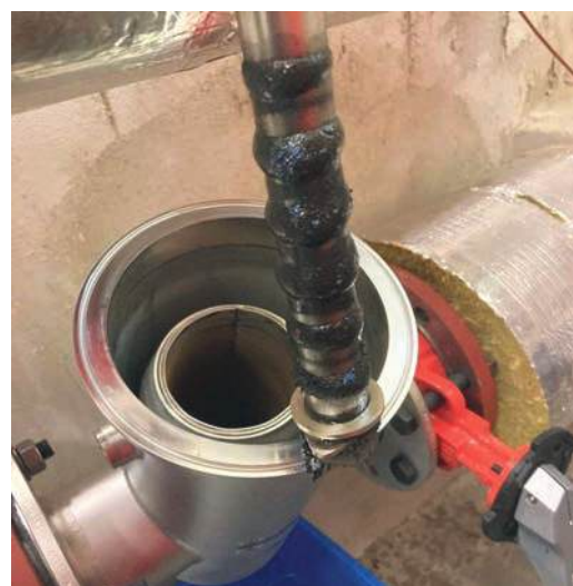
Servis filtru RD2.3 – magnet a filtrační vložka
